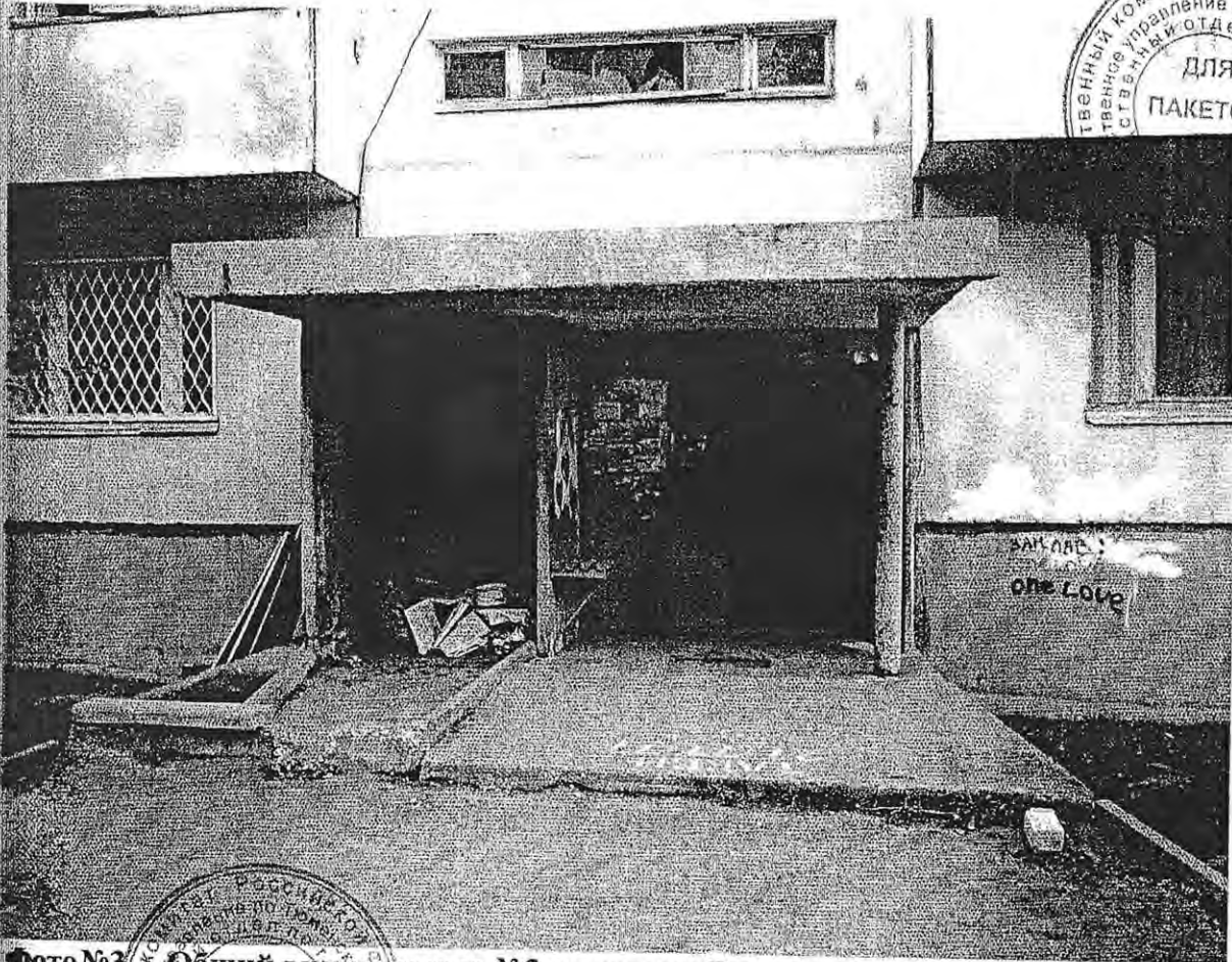
Фото №3. Общий вид подъезда №2 по адресу: Тюменская область, г. Тобольск, 10 микр., дом 24.
