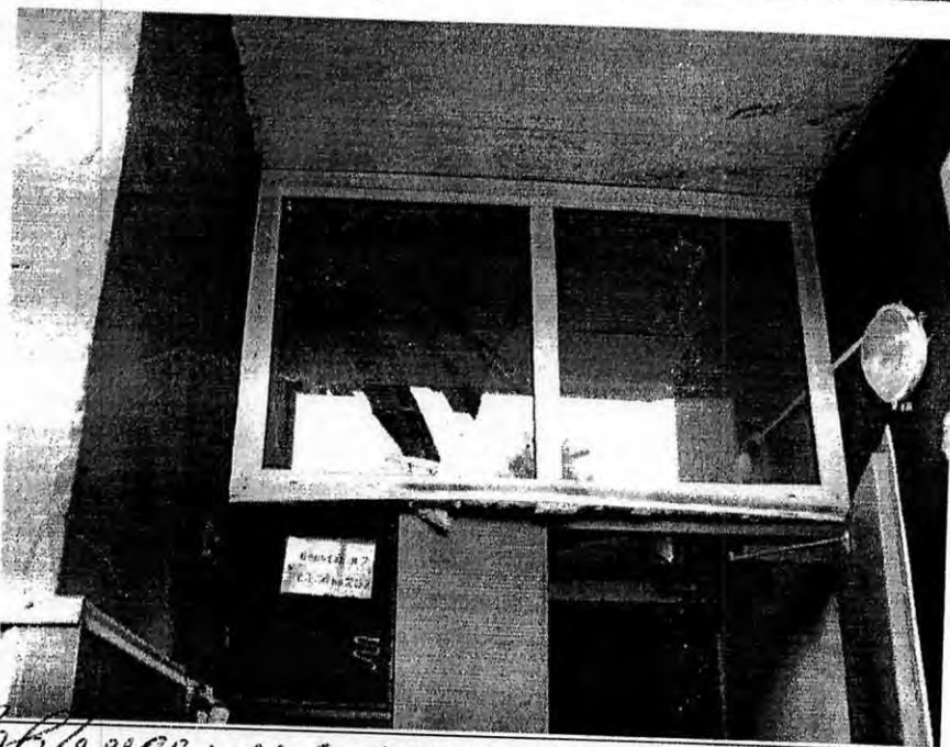
Фото №1 Вид из коридора в подъезд
