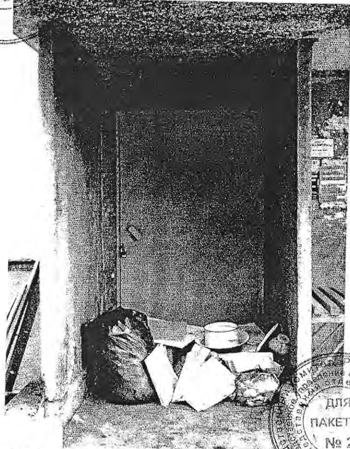
Вид двери ведущего в помещения для бытового мусора возле подъезда №2 дома №24 в 10 микр. г. Тобольска.
