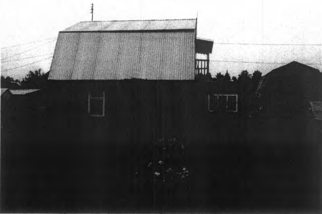
Фото № 3. Дом № 49 по ул. Плодовая дачного кооператива «Механизатор», расположенном на 263 км автодороги Тюмень-Ханты-Мансийск (вид со стороны дачного участка).
