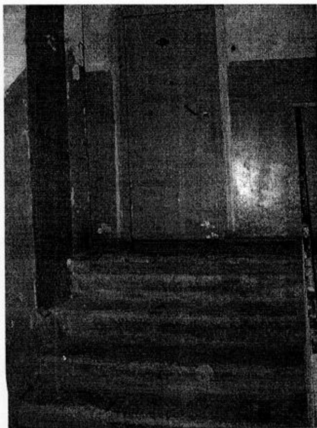
● фото №5. Вид на пролет лестничного марша к площадке 1 этажа.
