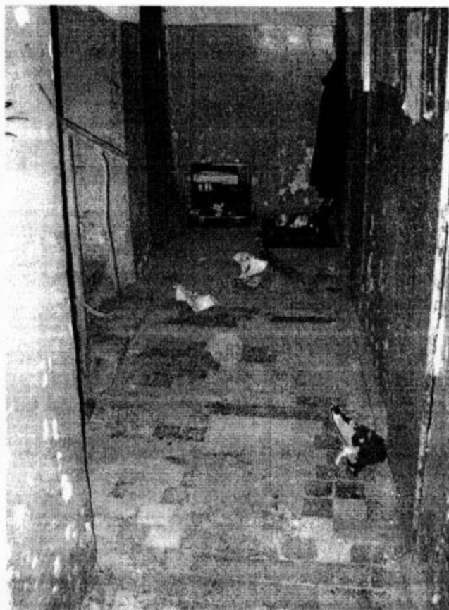
Фото №6. Общий вид площадки 1 этажа
