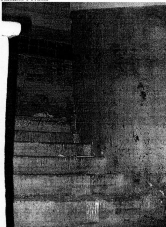
Фото №7. Общий вид лестничного пролета в площадке между 1 и 2 этажами.
