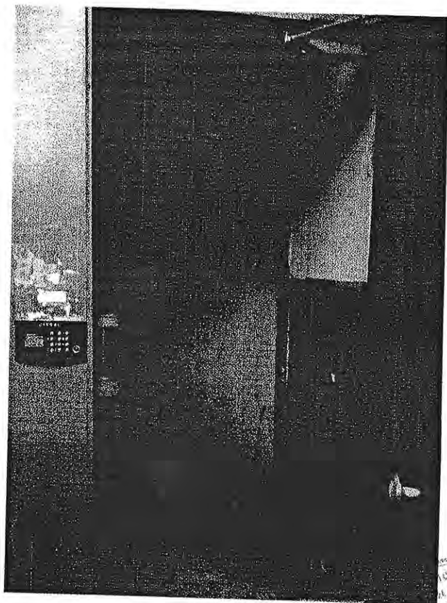
Фото №7. Тамбур подъездом №1 по адресу: Тюменская область, г. Тобольск, 4 микр., дом 14.
